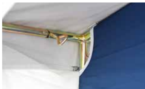
Struttura in acciaio
